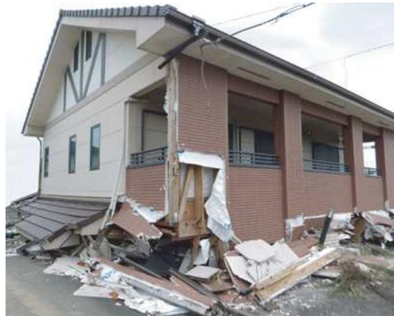
一階が倒壊した比較的新しい住宅（益城町）
